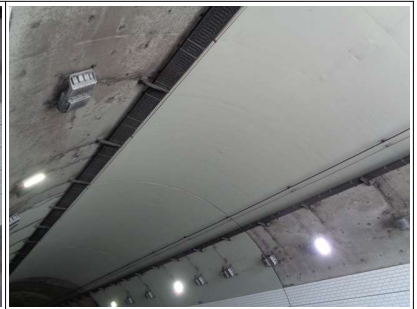
51 천단부 균열 SP54 보수
